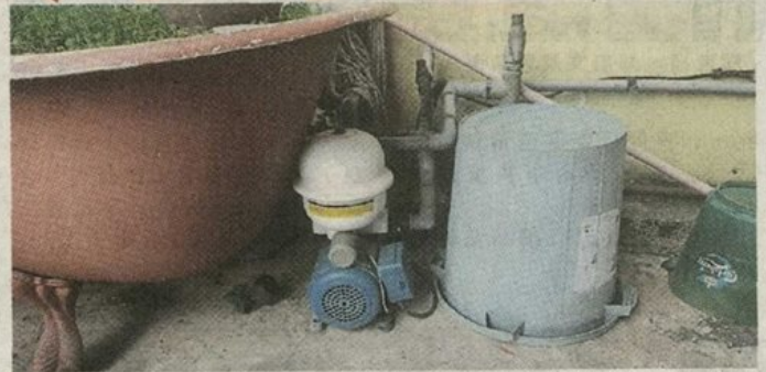
居民因为水压低和水流小，自来水无法泵入上方蓄水槽而自行购买水泵暂时解决问题。
