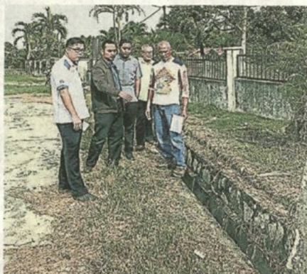
▲徐灶生（左）与官员和承包商巡视需提升的排水系统。
